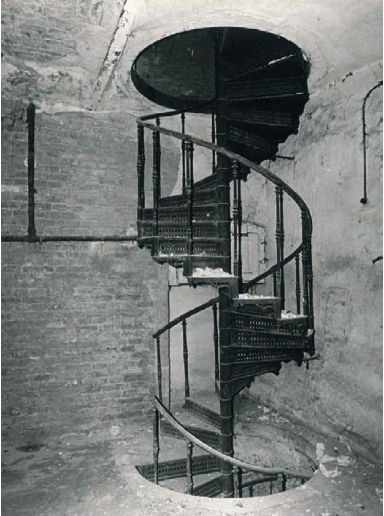
bel etage, das Untergeschoss vor der Renovierung bel etage, the basement before renovation
